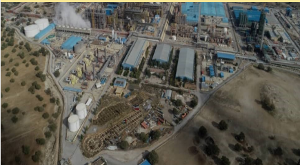
پروژه نگهداری و تعمیرات پتروشیمی ایلام
